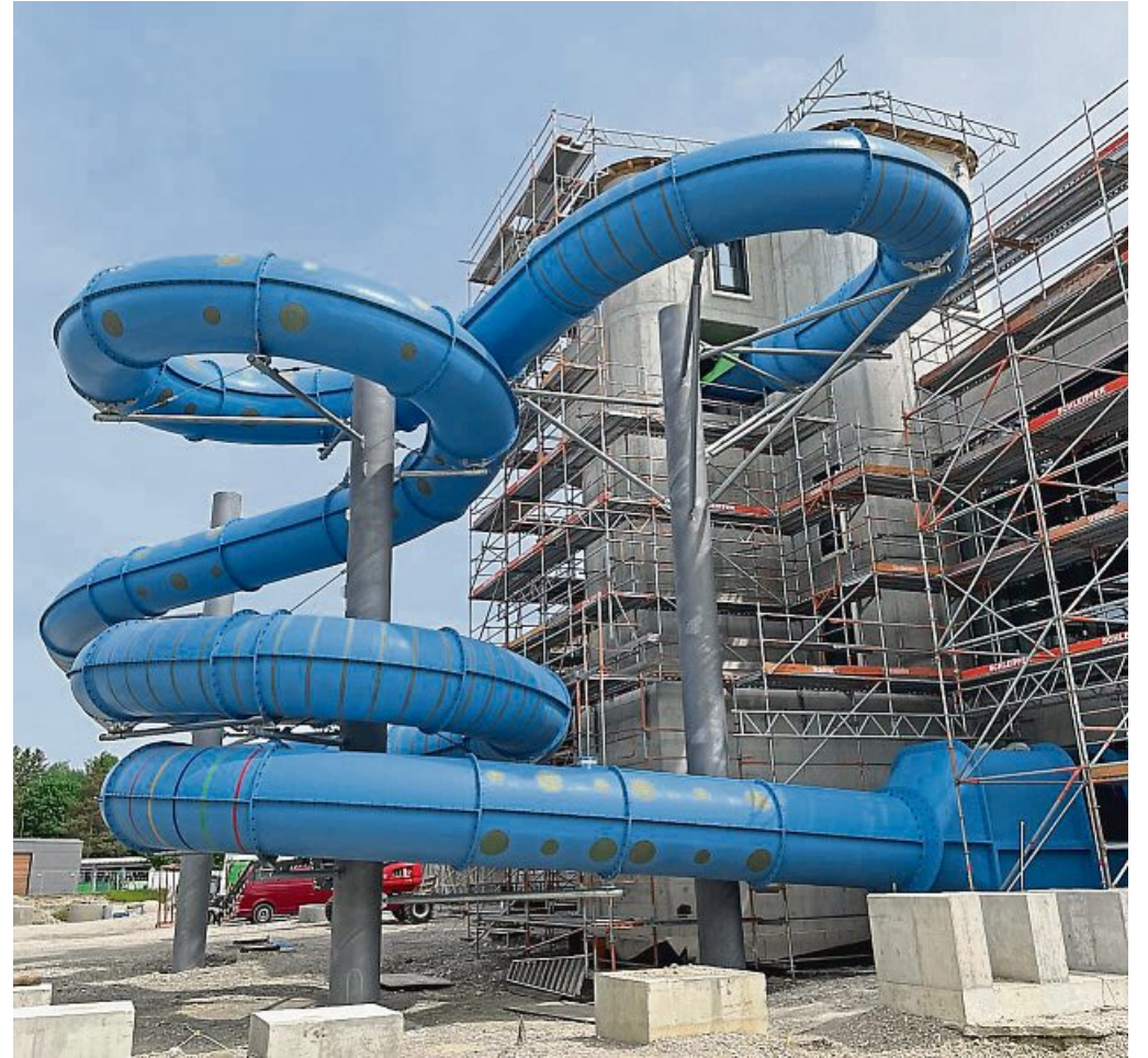
Die neue Rutsche am Penzberger Bad ist 110 Meter lang und startet in elf Metern Höhe – gerutscht werden kann mit und ohne Reifen.
